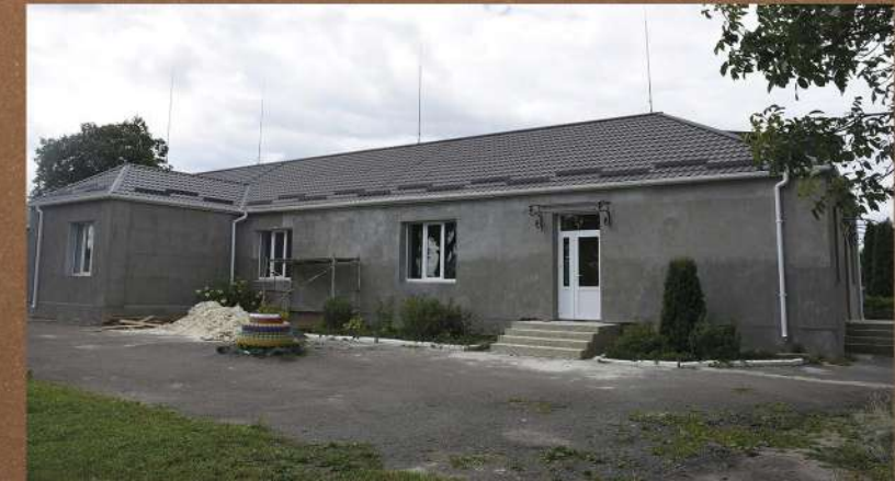
КАПІТАЛЬНИЙ РЕМОНТ ДАХУ ТА УТЕПЛЕННЯ ФАСАДУ ТАРАКАНІВСЬКОГО ДНЗ
