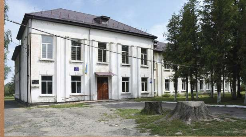
КАПІТАЛЬНИЙ РЕМОНТ ПЕРЕКРИТТЯ БУДІВЛІ РАЧИНСЬКОЇ ГІМНАЗІЇ
