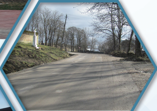
Капітальний ремонт вул.Л.Українки в с.Полупанівка (223 тис.грн)
