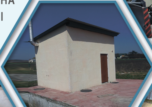
Будівництво очисних споруд. (720 тис.грн)
