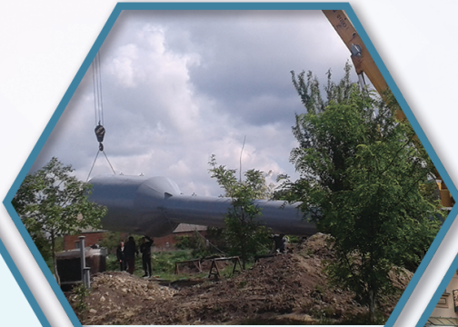
Будівництво системи водопостачання. Підземний водозабір. с.Магдалівка
