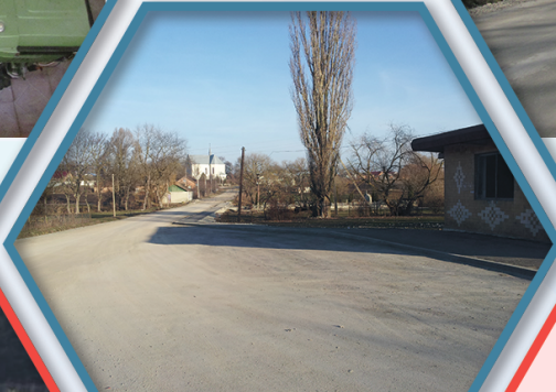
Капітальний ремонт вул.Мазури с.Остап'є (458 тис.грн)
