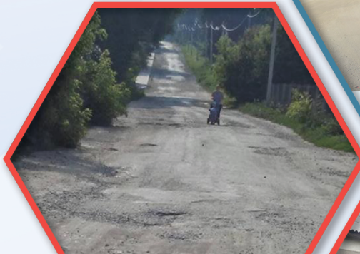
Капітальний ремонт вул.Незалежності, м.Скалат
