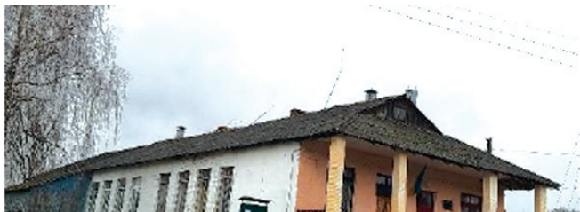
ПРОВЕДЕННЯ КАПІТАЛЬНОГО РЕМОНТУ ПОКРІВЛІ АДМІНПРИМІЩЕННЯ в с. Шубків по вул. Незалежності на суму - 1 471 116 грн
